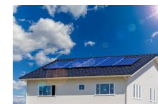
太陽光発電システム
