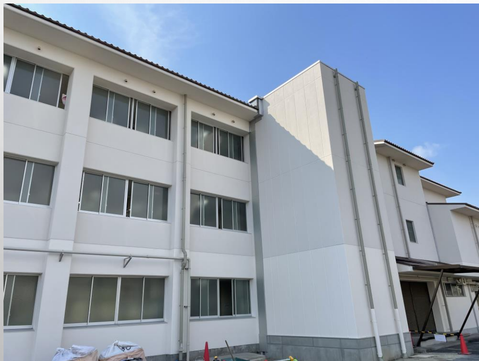
給食運搬用等 エレベーター(外観)
