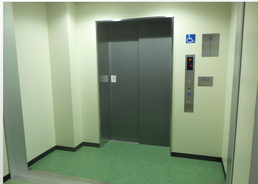
給食運搬用等 エレベーター
