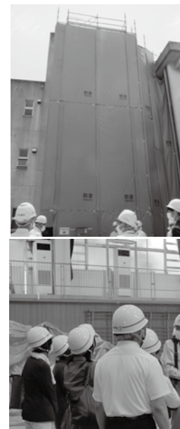
王寺義務教育学校(南)工事現場
