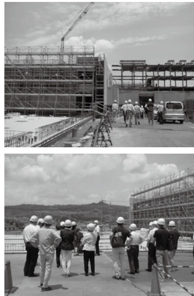
王寺義務教育学校(北)工事現場
