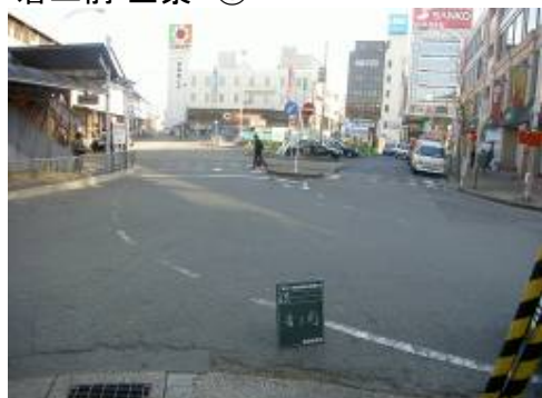
着工前 全景 ①
