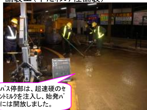
舗装工(半たわみ性舗装)
