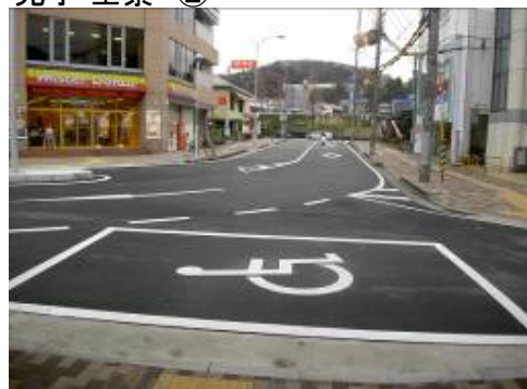
完了 全景 ②
