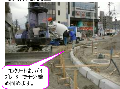
現場打街渠工
