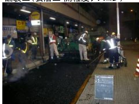
舗装工(表層工 開粒度アスコン)
