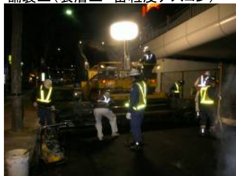
舗装工(表層工 密粒度アスコン)
