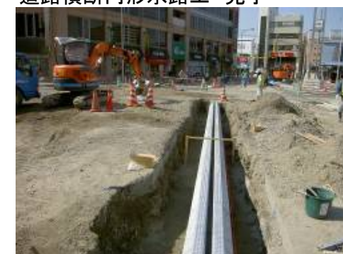
道路横断円形水路工 完了
