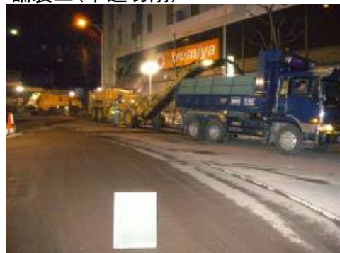
舗装工(車道切削)
