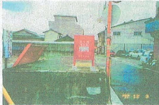
消火器設置②
