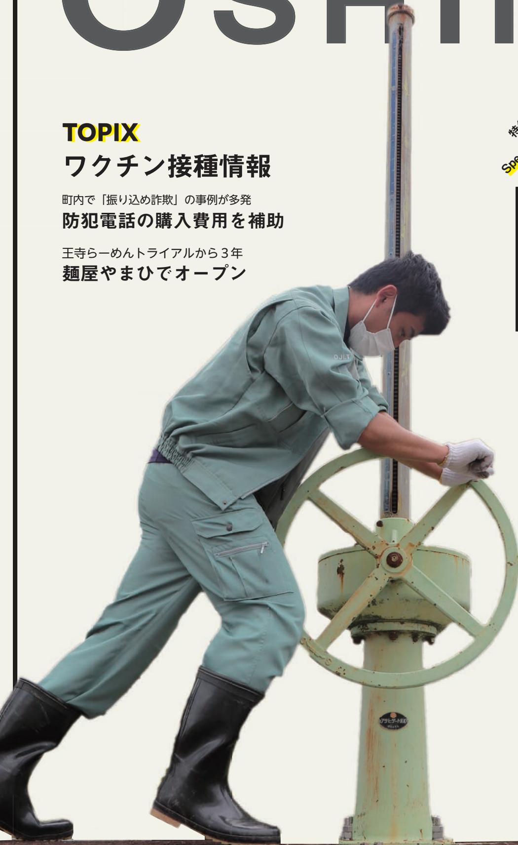
内水の排水のために、堤防を横切って設けられる水路のこと。樋門にはゲートが設置されており、洪水時には閉鎖して洪水が用水路、排水路に流入しないようにする。王寺町では、梅雨を迎える前に職員が点検を行う。
