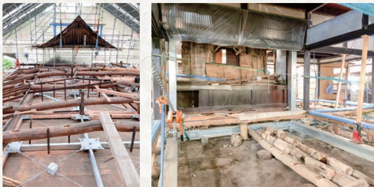
工事に耐震補強で入れられた鉄骨フレーム（左：屋根裏、右：床下と柱）
