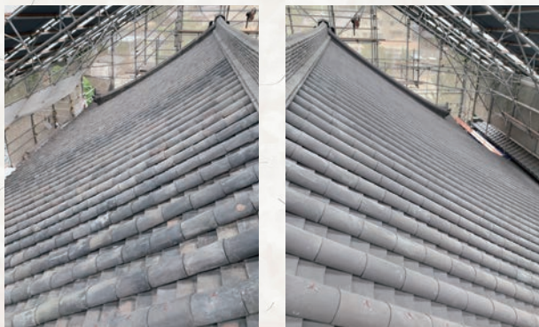
修理が完了した達磨寺方丈の屋根瓦 (左が南面の江戸時代の瓦、右が北面の現代の瓦)
