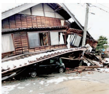
▶ 倒壊した家屋
