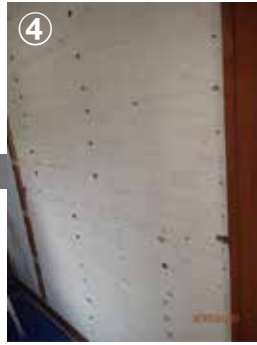
④ 合板を設置
