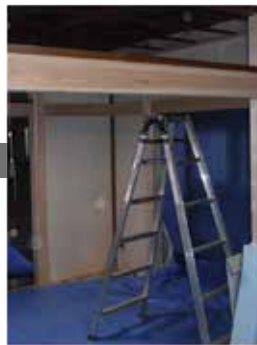
構造用合板を設置
