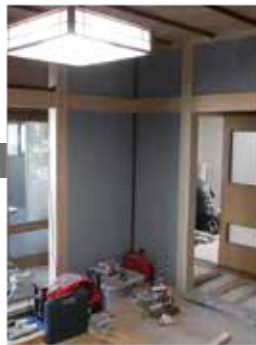
壁の下地を設置
