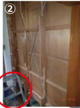
② 壁を剥がし金物とステンブレスで補強
