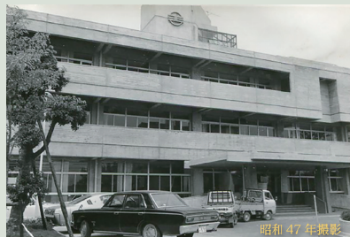
改築後の王寺町役場
