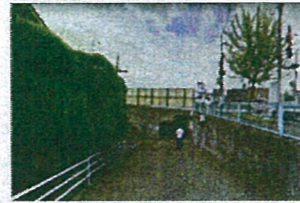
〈1〉王寺中学校～葛下川遊歩道トンネル
