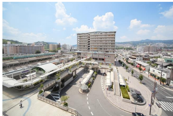
王寺駅北側ロータリーと県道王寺停車場線
