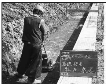
① 地面を掘り砕石を敷いて埋戻して、機械で転圧
