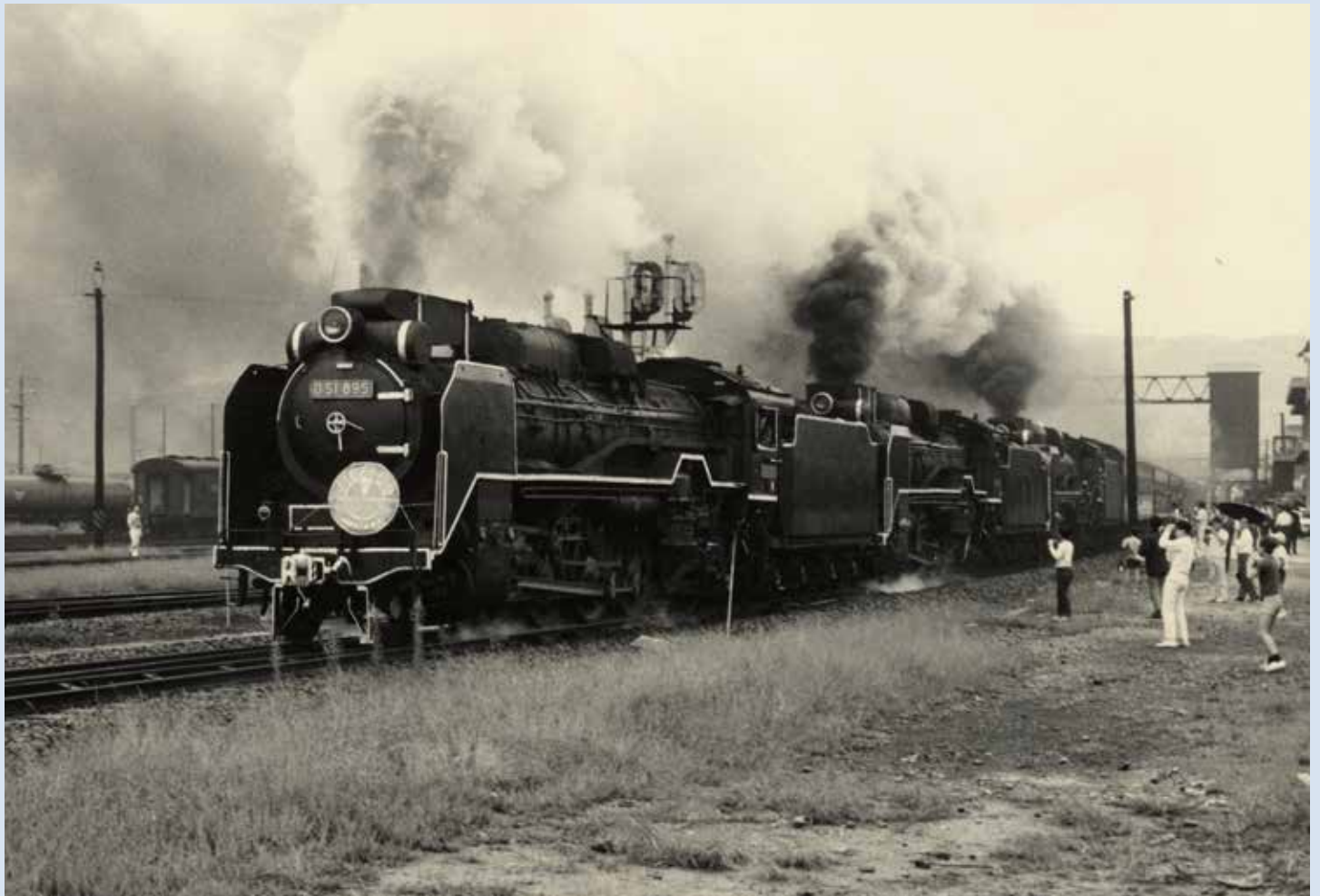
▲ 昭和46年（1971）9月26日、イベント列車 JC 赤トンボ号として三重連の先頭に立って王寺駅を走る D51形蒸気機関車895号機
