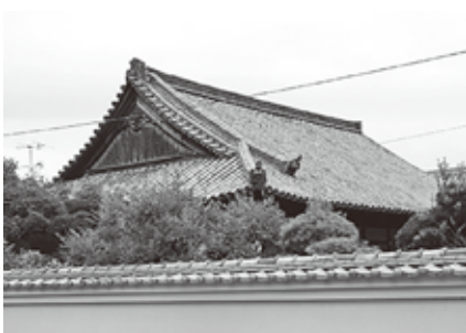
▲ 西側屋根の入母屋造
