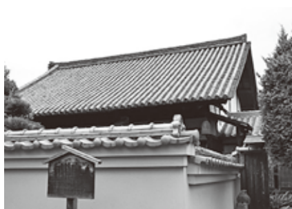
▲ 東側屋根の切妻造
