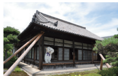
▲建設から350年が経過する「達磨寺方丈」
