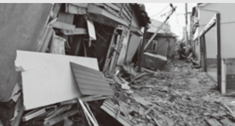
▲王寺町でも起こりえる地震による被害 (写真:平成7年阪神淡路大震災 神戸市提供)
