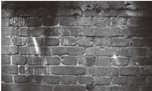
▲ レンガのイギリス積み部分
