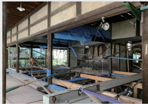
保存修理工事の方丈内部
