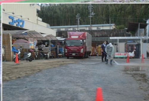
▲コーナン駐車場では堆積した泥の除去作業が行われていました。
