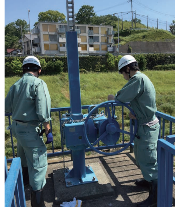
▲雨量が多くなる梅雨の前に、水防設備の点検を行っています。
