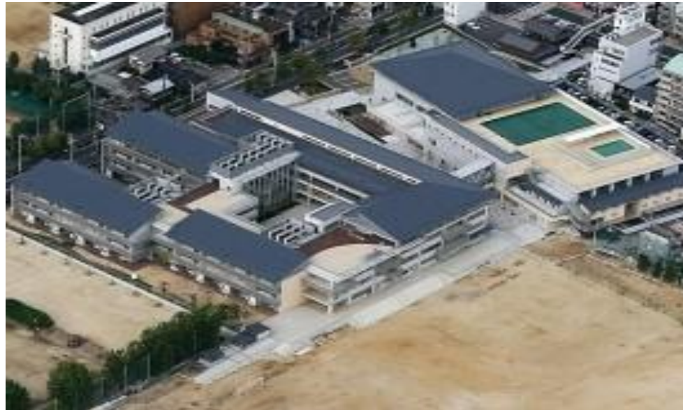
空から見た全景
